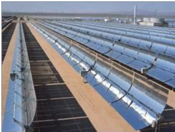
Obrázok 4. Parabolické žľabové polia strednej teploty (zdroj: ArséniureDeGallium, Verejná doména, cez Wikimedia Commons)
