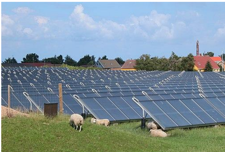
Obrázok 5. Centralizované zásobovanie teplom pomocou poľa solárnych tepelných kolektorov o rozlohe 18 300 m 2 . Dánsko, Marstal (zdroj: Erik Christensen, CC BY-SA 3.0 < https://creativecommons.org/licenses/by-sa/3.0/ >, cez Wikimedia Commons)
