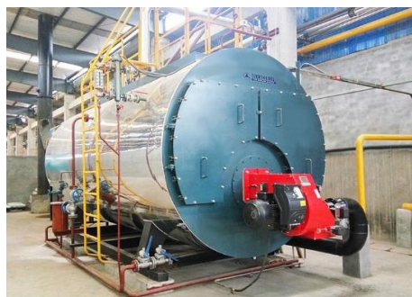
Obrázok 17. Parný kotol Winketel (zdroj: Diemareng, CC BY-SA 4.0 < https://creativecommons.org/licenses/by-sa/4.0/ >, cez Wikimedia Commons)
