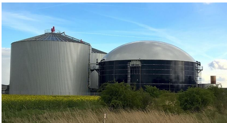
Obrázok 8. Bioreaktor typu CSTR (Continuous-flow Stirred Tank Reactor) na výrobu bioplynu (zdroj: geraldK (pixabay.com))
