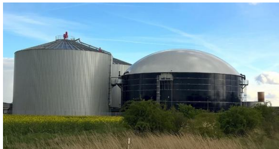
Rysunek 8. Bioreaktor CSTR (reaktor z mieszadłem o przepływie ciągłym) do produkcji biogazu (źródło: geraldK (pixabay.com))
