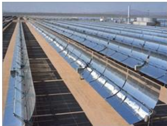
Rysunek 4. Układy parabolicznych kolektorów średnitemperaturowych (źródło: ArséniureDeGallium, domena publiczna, za pośrednictwem Wikimedia Commons)
