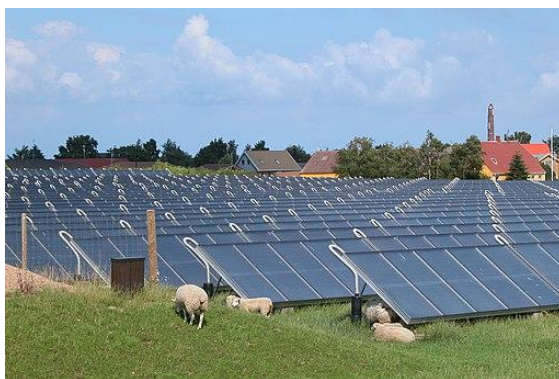
Rysunek 5. Ciepłownictwo lokalne wykorzystujące pole kolektorów słonecznych o powierzchni 18 300 m 2 . Dania, Marstal (źródło: Erik Christensen, CC BY-SA 3.0 ( https://creativecommons.org/licenses/by-sa/3.0 ), za pośrednictwem Wikimedia Commons)
