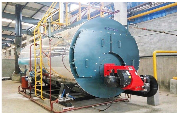
17 paveikslas. Vamzdinis garo katilas Winketel (kreditas: Diemareng, CC BY-SA 4.0< https://creativecommons.org/licenses/by-sa/4.0/ >, via Wikimedia Commons
