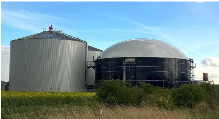
8 paveikslas. Biodujų gamybai skirtas biodujų reaktorius CSTR (Continuous-flow Stirred Tank Reactor) (kreditas: geraldK (pixabay.com))
