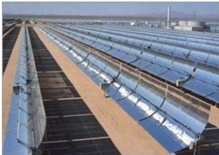
4 paveikslas. Vidutinės temperatūros parabolinių lovių masyvai (kreditas: ArséniureDeGallium, Public domain, via Wikimedia Commons)
